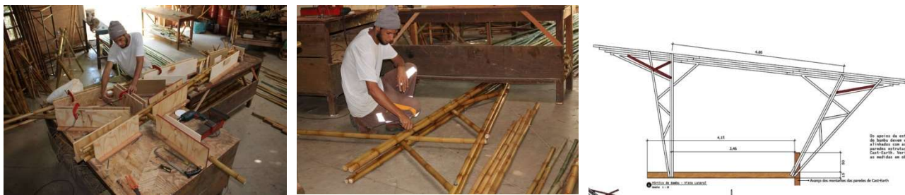
Figura 2 – Pré-fabricação de componentes estruturais do estudo de caso 6
