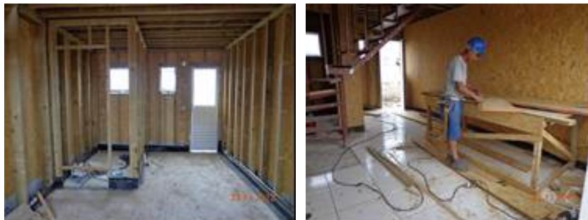
Figura 6 – Colocação das chapas OSB nos painéis aberto em canteiro
