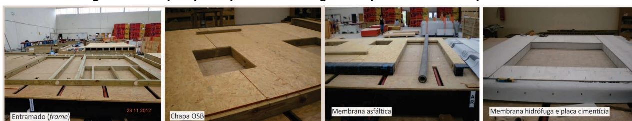
Figura 4 – Etapas principais da montagem do painel aberto de parede na fábrica
