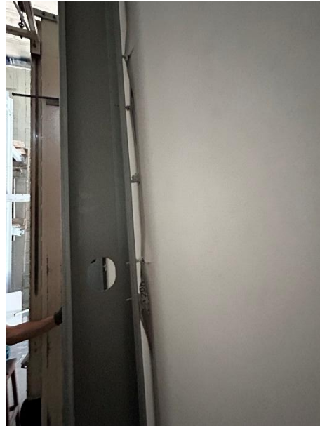
Figura 11 – Visualização da ruptura das ligações parafusadas das chapas de fechamento externo nos montantes, observadas durante o ensaio de cargas uniformemente distribuídas
