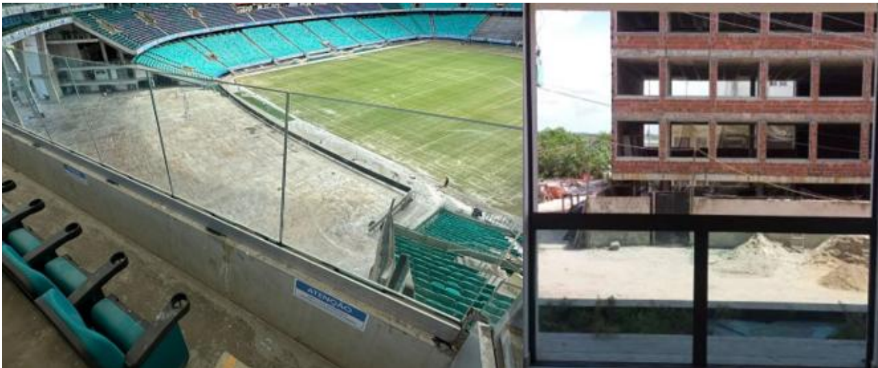
Figura 3: Guarda-corpos do tipo vidro autoportante (à esquerda) e do tipo peitoril de janela (à direita)
